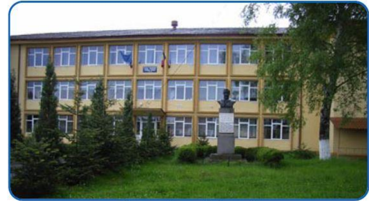
Haupteingang, Front zur Meschner Straße
