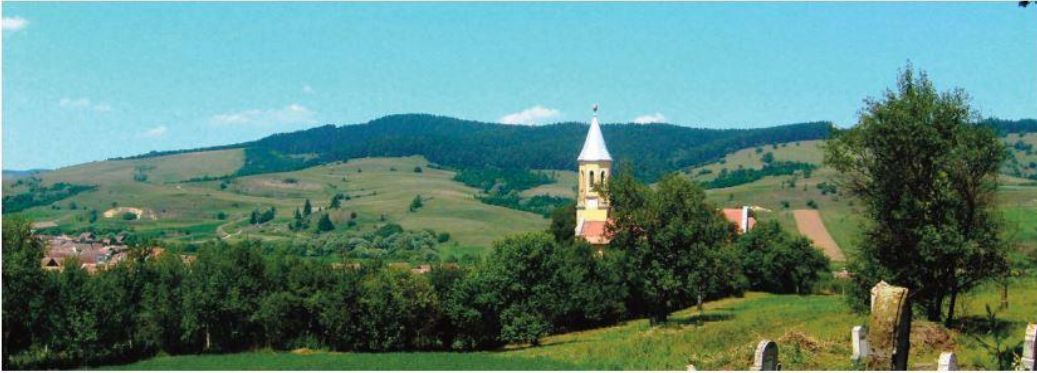
Seiburg im Haferland, Siebenbürgen
