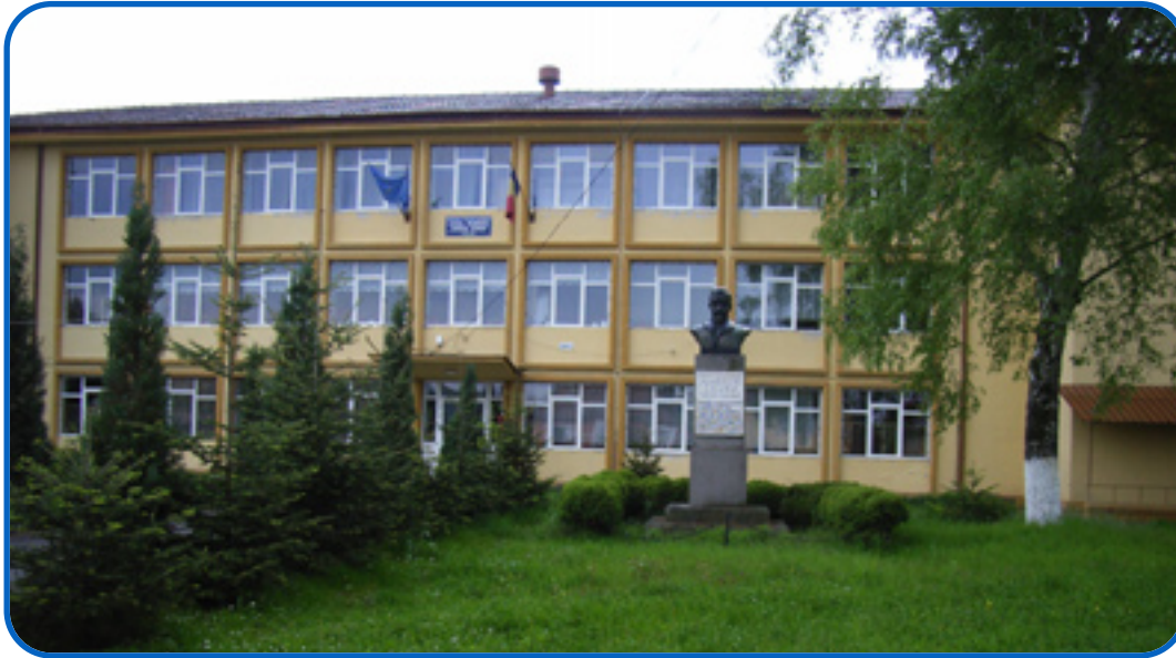
Haupteingang, Front zur Meschner Straße
